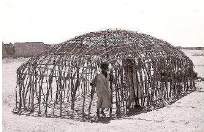
Fig. 18 : Una "zeriba" in fase di costruzione
