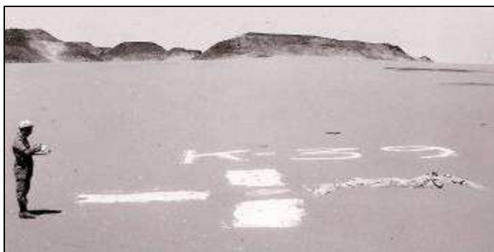
Fig. 8 : Segnali di controllo dei rilievi aereofotogrammetrici
