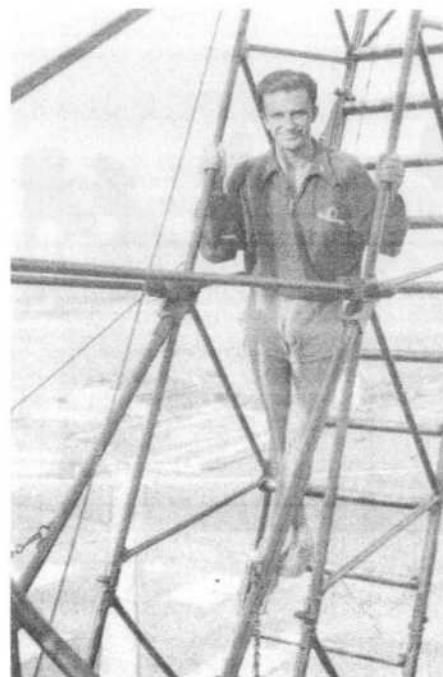
Luglio '41: Errani in cima alla «Torre». Sullo sfondo le strutture dell'aeroporto «Sostegni».
