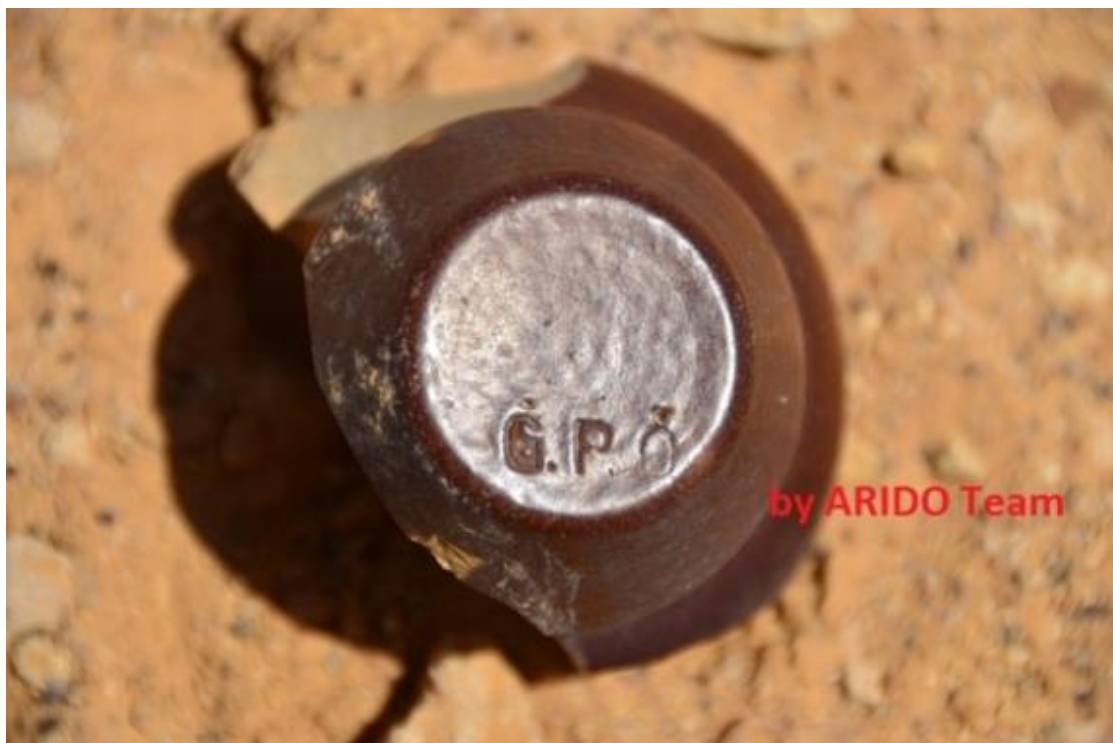
Isolatori della palificata prodotti da due diverse ditte
