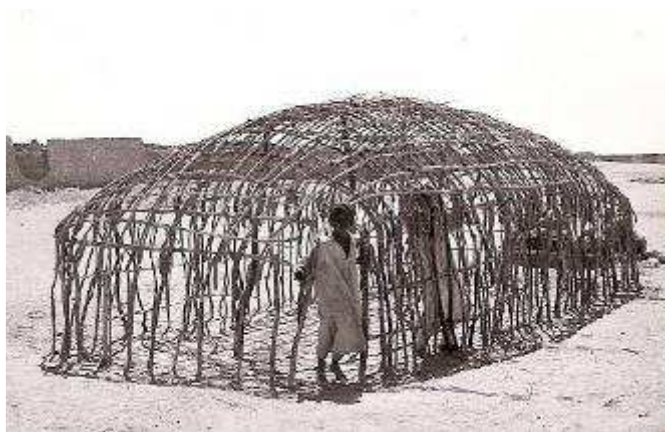
Fig. 18 : Una “zeriba” in fase di costruzione
