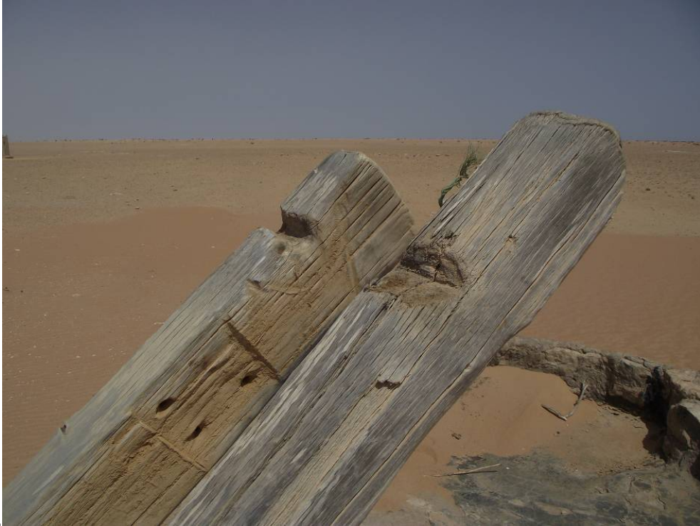
Particolare degli incassi dove viene messa in bilico la carrucola che viene stabilizzata dal peso del contenitore pieno di acqua durante la risalita alla superficie.
