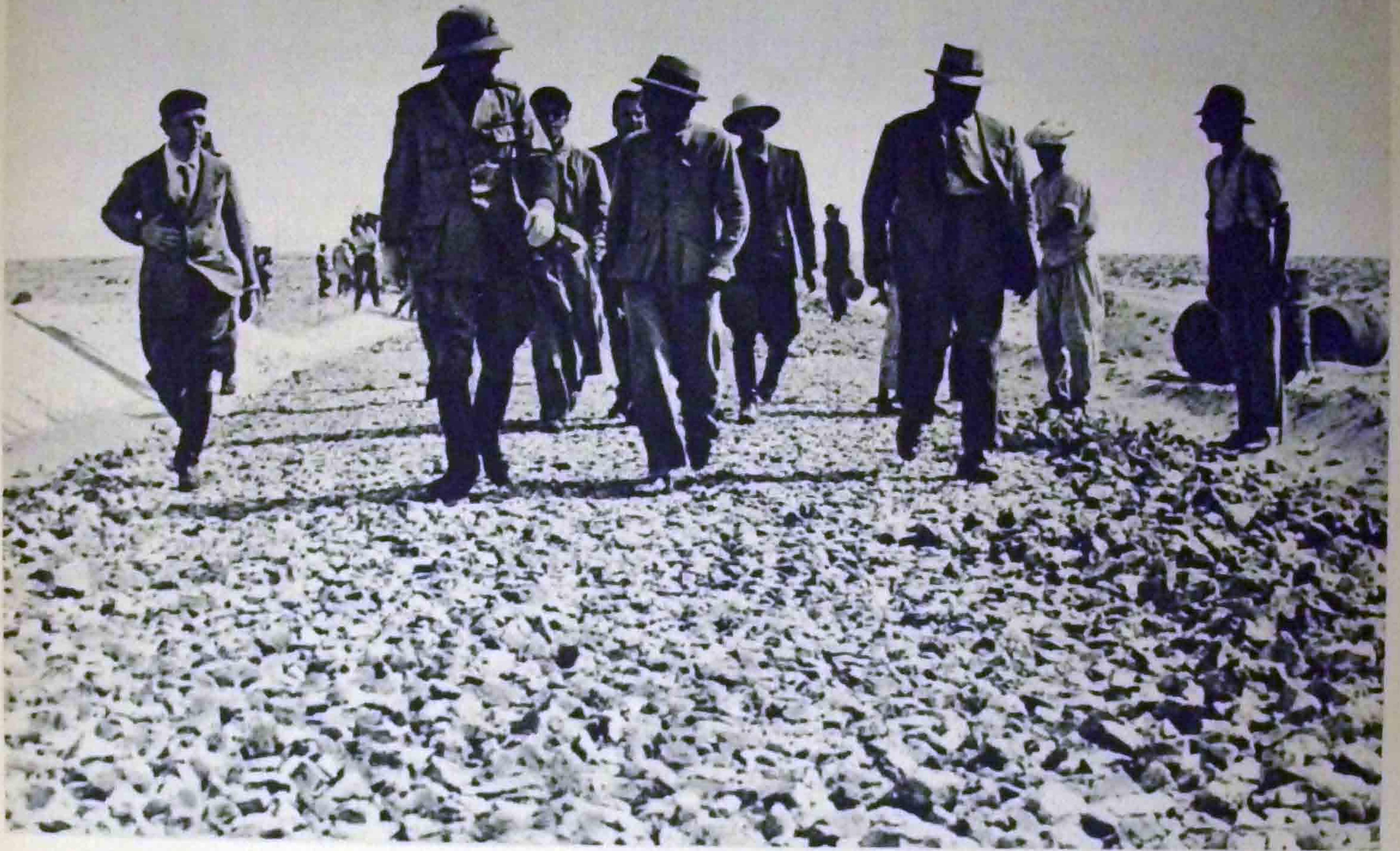
Ispezione ad un tratto della strada durante i lavori di massicciata
