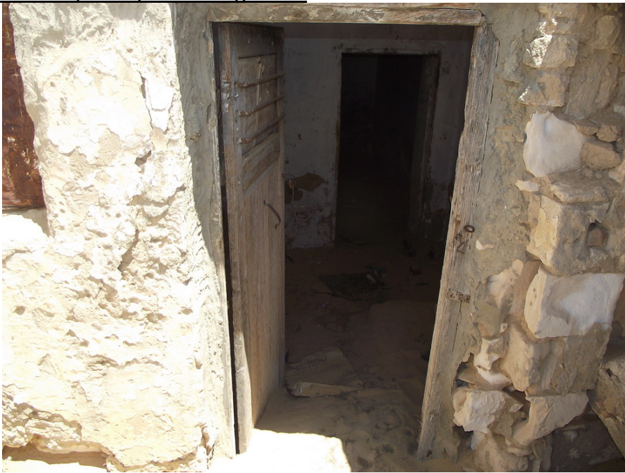
Ingresso posteriore (lato ferrovia) con la porta in legno (l'unica rimasta)
