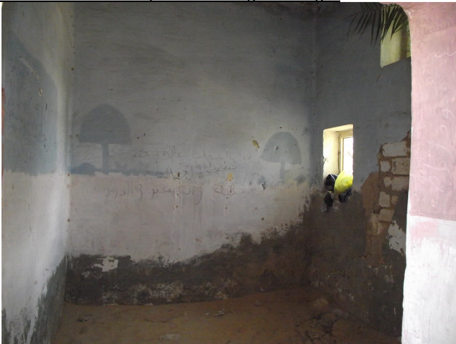
Altra stanza che presenta, sotto alcune mani di vernice di colore diverso, la colorazione grigia originale di tutta la costruzione.
